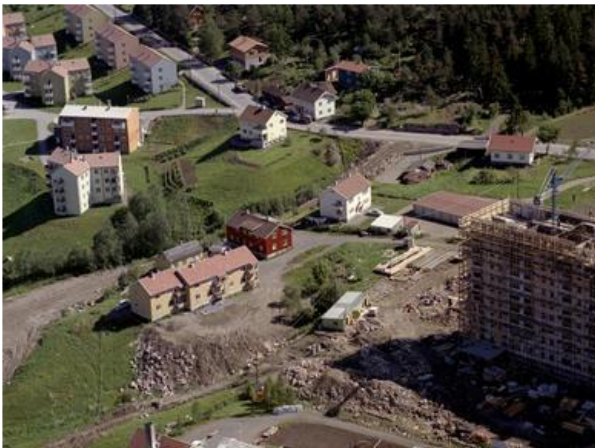
Figur 5 Byggingen av høyblokka på Grorud senter. Anleggsveien bak det røde huset midt i bildet er traseen til den senere Grorudbanen. Veien i bakgrunnen er Bergensveien, med Hagelundveien som forgrener seg ned til venstre. Foto: 1962 Widerøes Flyveselskap/ Oslo byarkiv.
