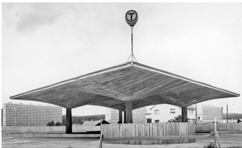
Figur 8 Nedgangen til T-banen. Ukjent datering Foto: T. Wold Anthonsen/ Oslo bya. Kilde: Oppdrag Grorud. 1966
