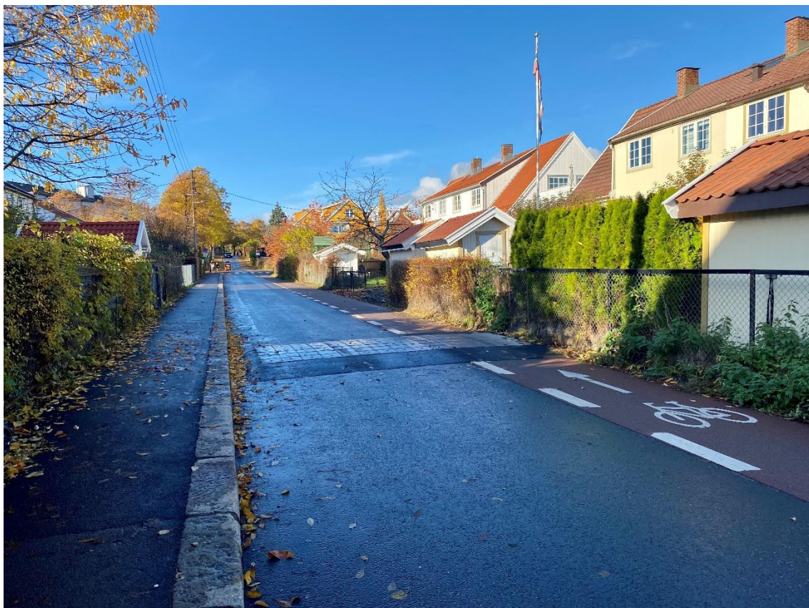
Figur 3-2. Eksempel på enveisregulert boliggate og sykkelfelt mot kjøreretning for bil. Løsningen er særlig egnet i boliggate med lav trafikk. Fjerning av gateparkering gir også bedre vilkår for utrykningskjøretøy. Kilde: Google streetview (øverst). Foto Asplan Viak (nederst).
